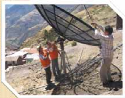
Realizando el mantenimiento del sistema, Distrito de Ocoyo - Pacamarca
